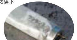
飛散防止膜により、ガラス片の飛散は認められない
